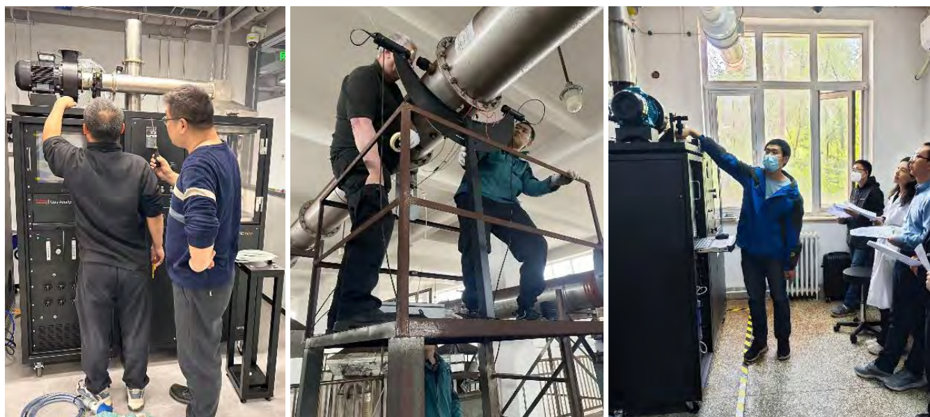
FTT某些设备安装现场
