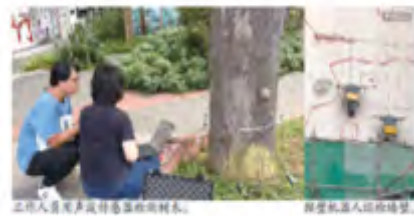
工作人员使用爬壁机器人检测树木。 爬壁机器人检测场景。
