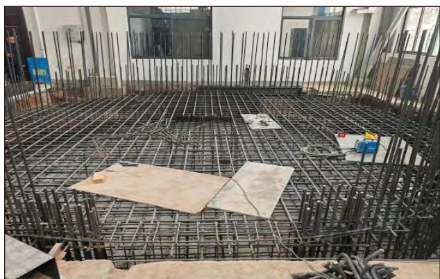
基础及侧墙钢筋绑扎
