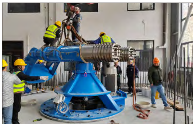
离心机吊装机械安装
