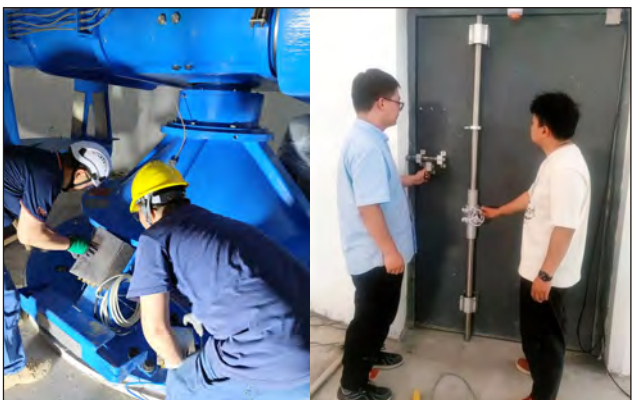
电控系统安装
