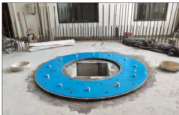
离心机底盘锚固安装
